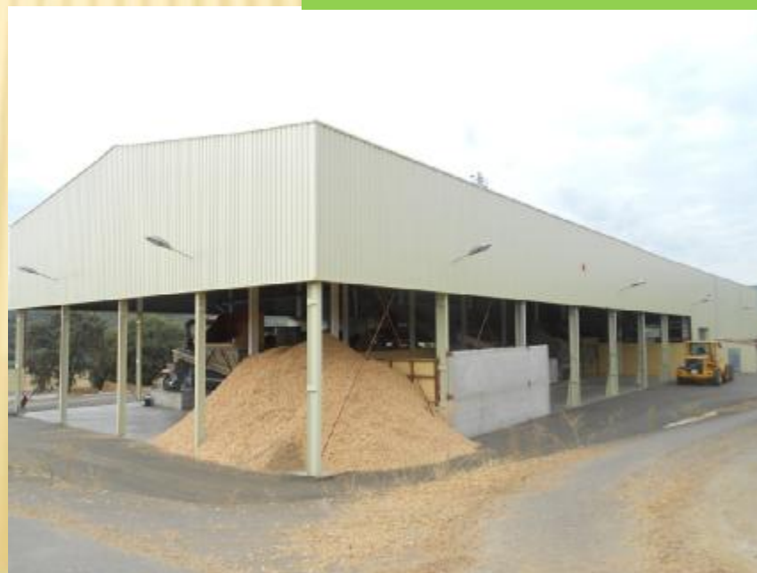
Nave de acopio
