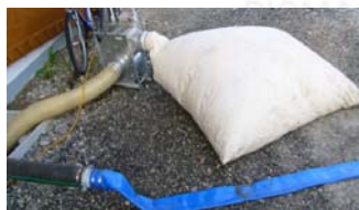
Filtraje de polvo de venteo en operación de carga de silo.
