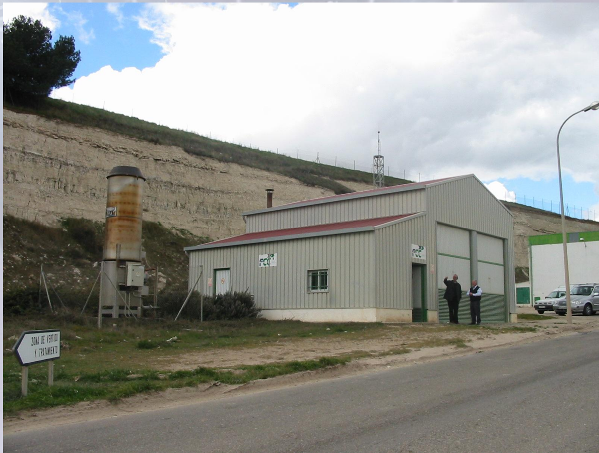
Edificio de bombas y motor. Antorcha
