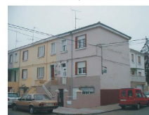
C/ SANTO TORIBIO, 11. ESTADO PREVIO.
