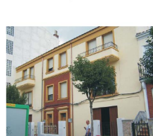
C/ SAN MATEO, 5. ESTADO ACTUAL.
