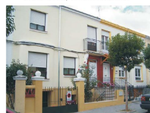
C/ SAN MATEO, 10. ESTADO ACTUAL.
