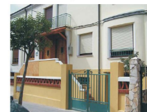
C/ SAN MATEO, 28. ESTADO ACTUAL.
