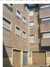
C/ PABLO FLÓREZ, 7 y 9. ESTADO PREVIO.
