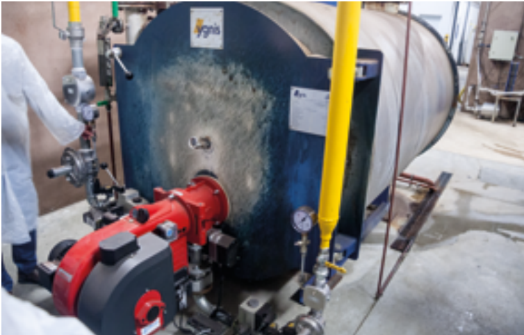
Caldera con quemador de biogás en la industria cliente
