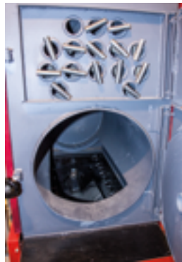
Turbuladores en el interior de los tubos del intercambiador de calor.
