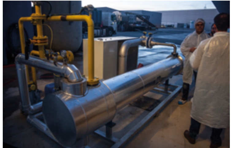
Acometida del biogás a la industria cliente
