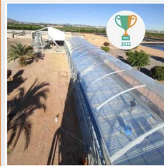
Secado solar y gasificación de lodos de depuradora
